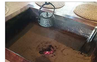
火気使用室の内装制限(内装を燃えにくい材料にすること)の範囲を限定し、囲炉裏等のある室で木材仕上げを可能とした
