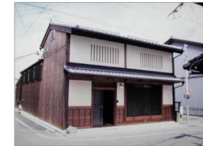
準防火地域等において、伝統的構法の土塗り壁や木造の軒裏の仕様を一般的に利用可能とした
