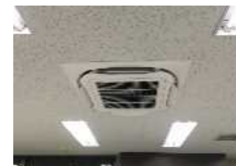
換気設備の導入
