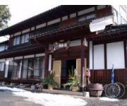
古民家の改修等
