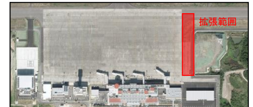
新石垣空港エプロン拡張事業
