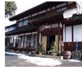
古民家の改修等
