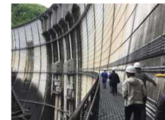
点検施設見学 （川治ダム（鬼怒川・栃木県））
