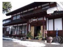
古民家の改修等
