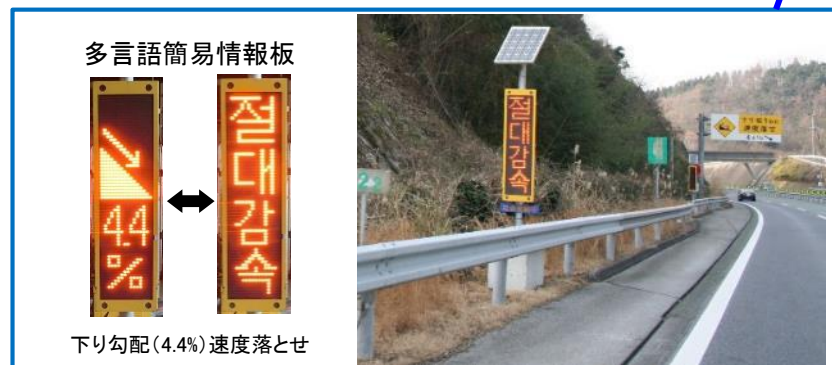
<大分自動車道における対策事例>
