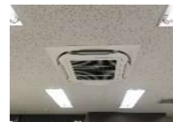
換気設備の導入
