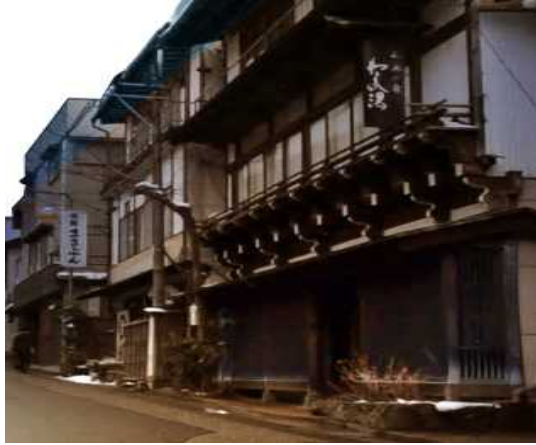
老朽化した施設
