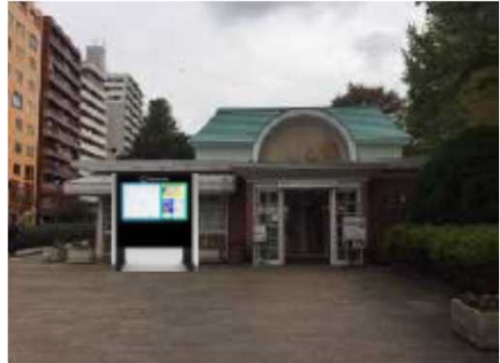
デジタルサイネージの設置
