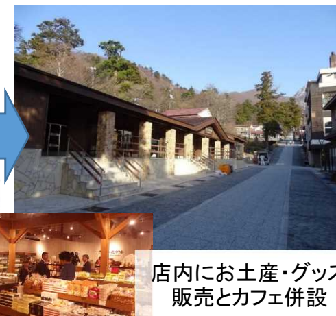
撤去前の廃屋
