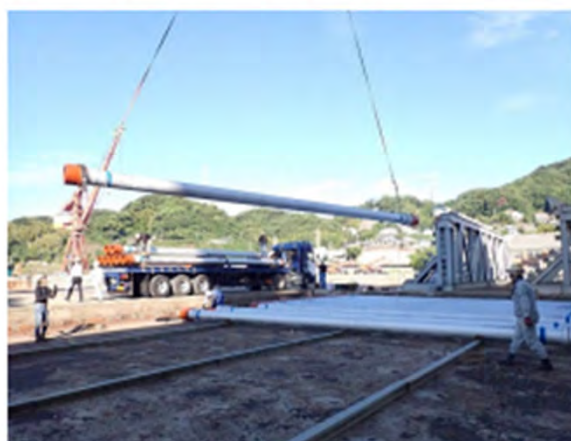
クレーンで1本ずつ荷下げ
