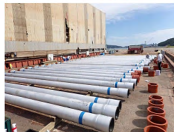
検査のため並べた揚泥管
