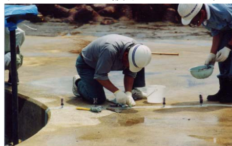
クラックの補修状況(注入工)
