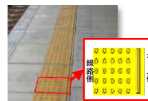
線路設備の修繕
