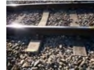
線路設備の修繕
