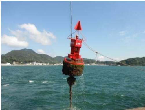
灯浮標の定期交換
