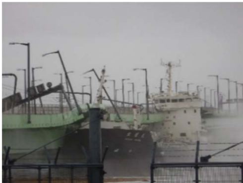
平成30年9月(台風第21号) 関西国際空港連絡橋へ油タンカー衝突
