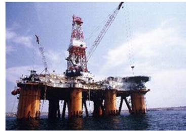
海上大型掘削装置
