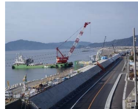
海岸堤防の耐震対策(高知県南国市)
