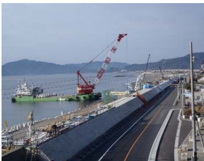
海岸堤防の耐震対策(高知県南国市)
