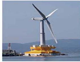
福島沖の5MW浮体式風車「ふくしま浜風」
