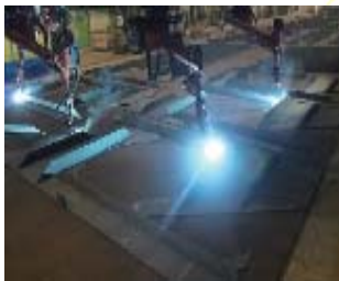
技術開発への支援 (例:自動溶接ロボット)
