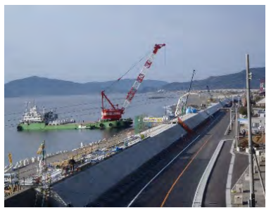
海岸堤防の耐震対策(高知県南国市)
