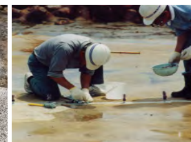
クラック補修状況(注入工)
