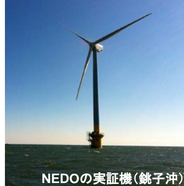
【洋上風力発電設備のイメージ】
