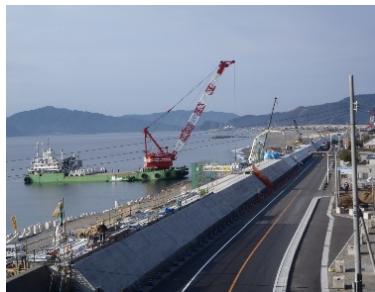
海岸堤防の耐震化工事(高知県高知海岸)
