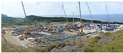
現在建設中の与那国駐屯地(仮称)
