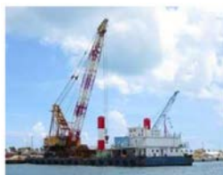
施工クレーン台船
