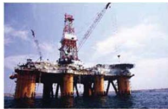
(海上大型掘削装置)
