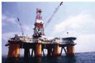
(海上大型掘削装置)
