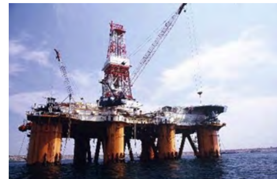
（海上大型掘削装置）
