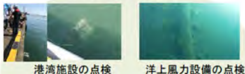
港湾施設の点検
