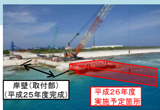
岸壁工事の状況(南鳥島)
