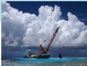
南鳥島における浚渫工事の状況
