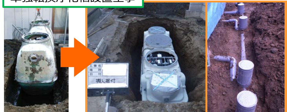
単独浄化槽撤去
