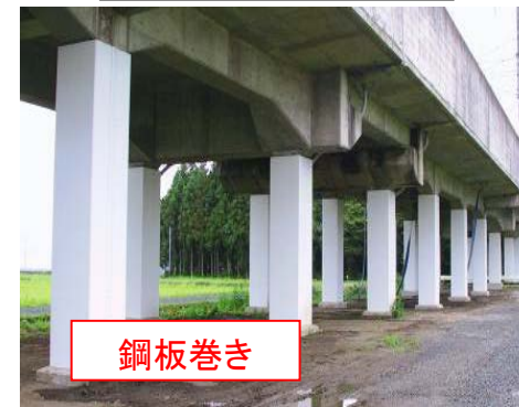
鋼板巻きによる耐震補強
