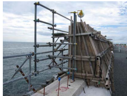
<既存護岸の嵩上げ>
