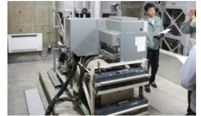
非常用電源の設置
