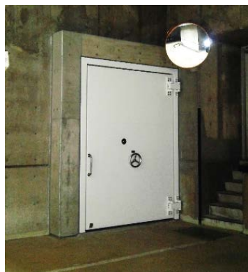
<止水扉の設置>
