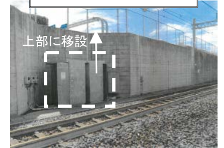
電源設備等の移設
