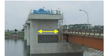
耐震不足が生じている箇所を補強(堰柱の巻立)
