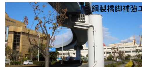
橋脚補強工
