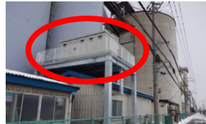
電気系設備の嵩上げ
