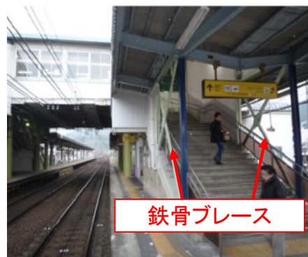
鉄骨ブレースによる耐震補強
