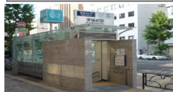
防水扉等の設置
