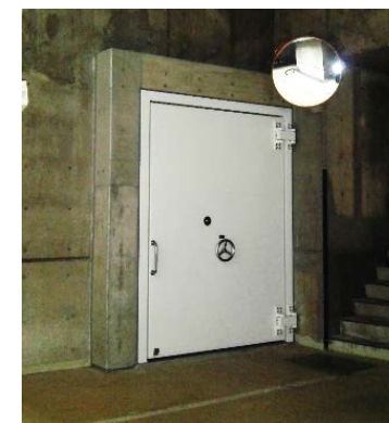
<止水扉の設置>
