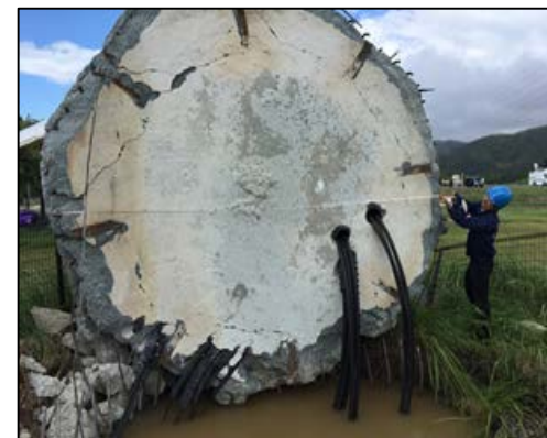
台風20号により倒壊した風力発電設備
