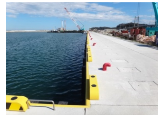
岸壁の耐震強化
