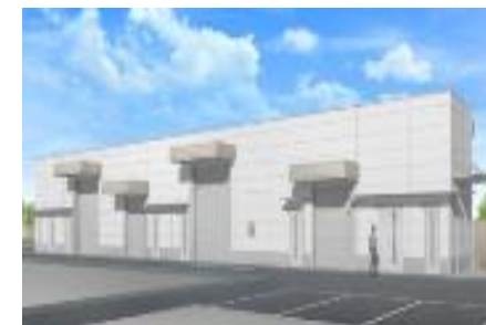
大型蓄電池システム試験評価施設を利用する事業者の資材保全及び作業者の安全確保(大阪事業所)
