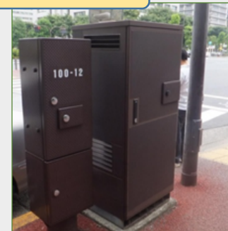
信号機電源付加装置
