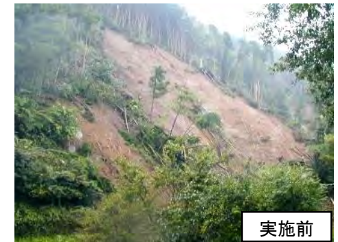
山腹崩壊地の復旧整備
