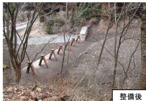
流木捕捉式治山ダムの設置
