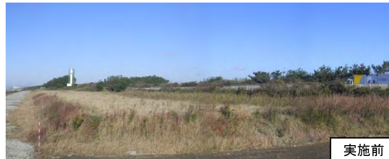
海岸防災林の整備 (植栽工の実施)
