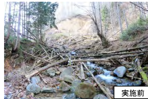
荒廃溪流の復旧整備
