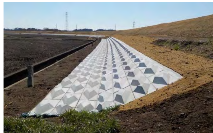
法尻補強の事例(久慈川)
