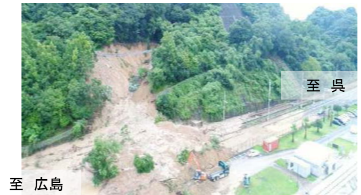
にほ くれ 広島呉道路（仁保IC～呉IC）の被災状況
