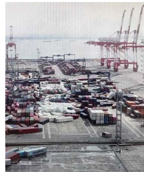
神戸港六甲アイランドRC6/7の被災状況
