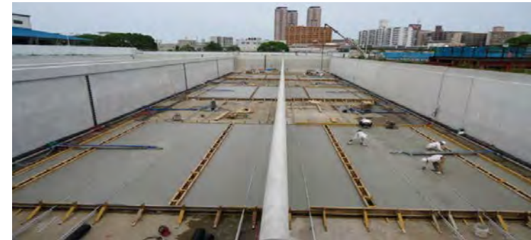
浄水場の耐震化工事(内面からの壁等の補強)
