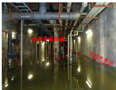
(左) 設備室が冠水 (右) 設備室内の自家発電設備が水没、故障し、起動せず
