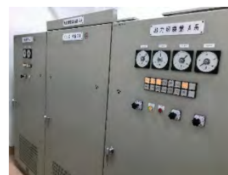
(左) 設置後30年経過した非常用電源装置：不具合発生の可能性が極めて高く、災害時に深刻な影響を及ぼす危険性が高い。
