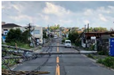
電柱倒壊による道路閉塞
