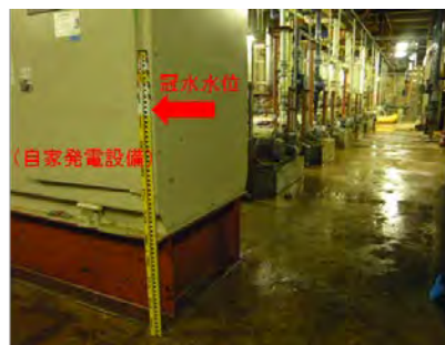
(左) 設備室が冠水 (右) 設備室内の自家発電設備が水没、故障し、起動せず
