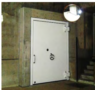
<止水扉の設置>
