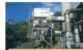
老朽化した処理施設
