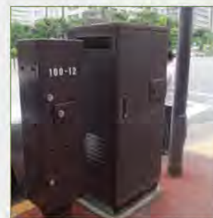
信号機電源付加装置
