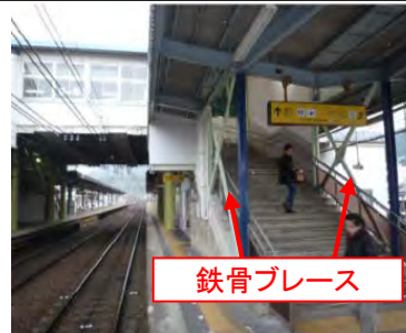
鉄骨ブレースによる耐震補強
