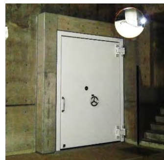
<止水扉の設置>
