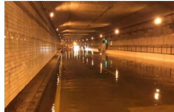
高潮により冠水したトンネル
