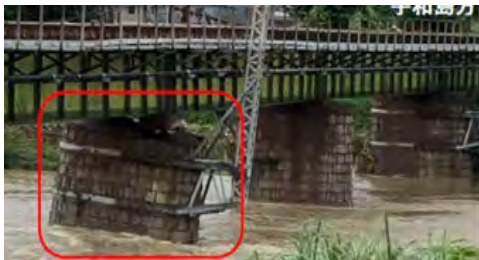
平成30年7月豪雨により傾斜した橋脚
