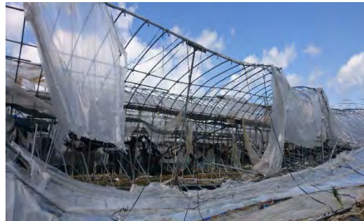
台風により倒壊したハウス
