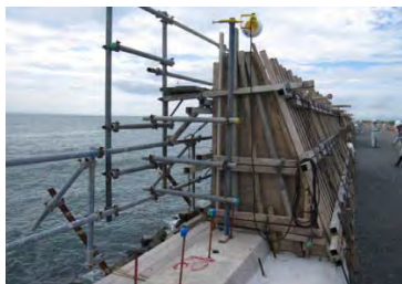
<既存護岸の嵩上げ>
