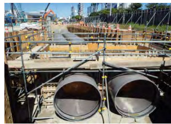
<排水機能の強化(配水管の改良)>
