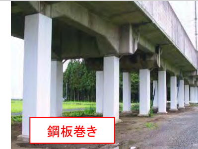
鋼板巻きによる耐震補強
