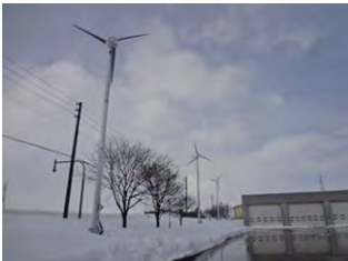
避難所に設置した風力発電
