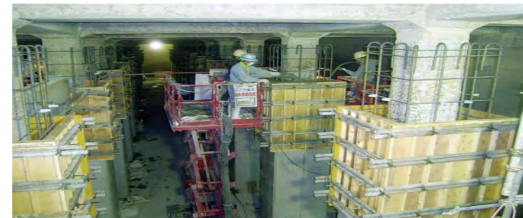
配水池の耐震化工事(内面からの壁・柱等の補強)
