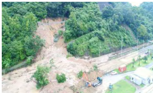
平成30年7月豪雨により崩壊した斜面
