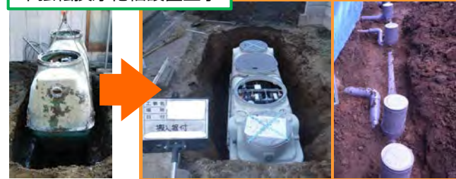
単独浄化槽撤去
