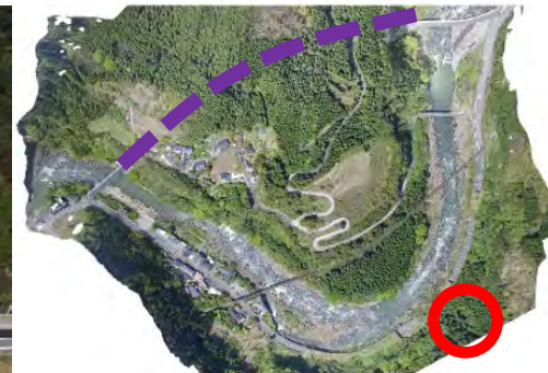
落石発生箇所
