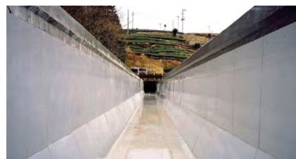
劣化部位を補強し、機能を確保
