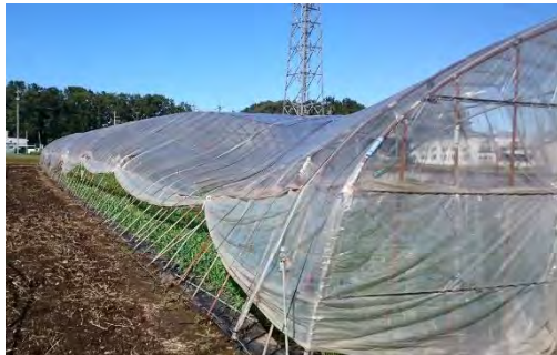
台風により倒壊したハウス
