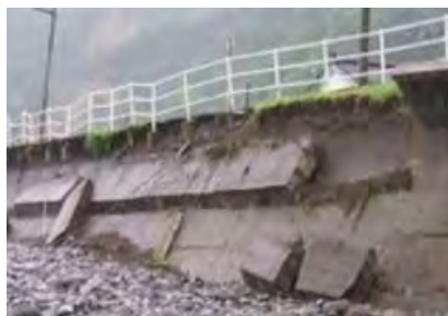
胆振東部地震における臨海部での被害 H19 新潟県中越沖地震における護岸の被災
