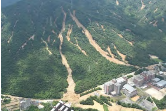
山地災害の発生状況(平成30年7月豪雨)
