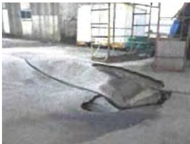
胆振東部地震における臨海部での被害 H19 新潟県中越沖地震における護岸の被災
