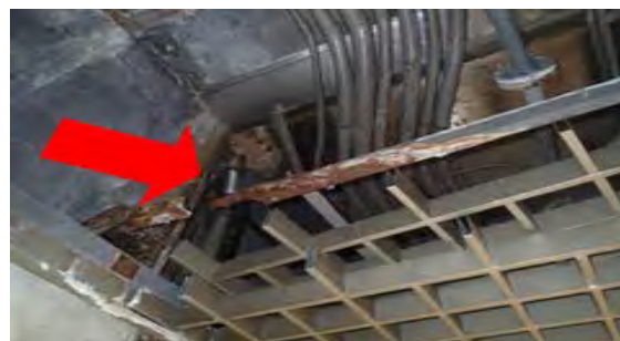
部材の破断
