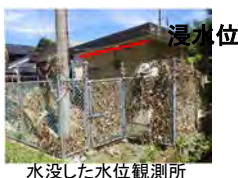
水没した水位観測所
