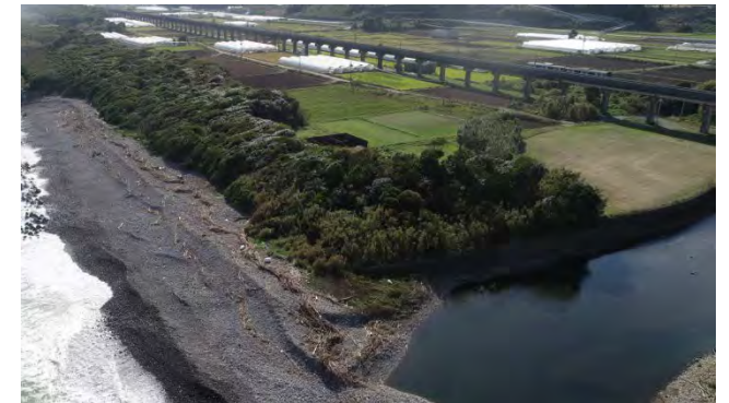
波浪により海岸の侵食を受けた海岸防災林
