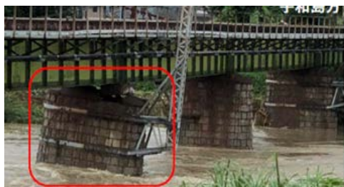
平成30年7月豪雨により傾斜した橋脚
