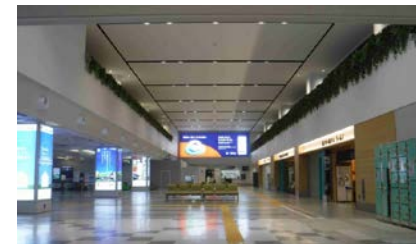
<ターミナルビルの吊り天井の事例(耐震対策後)>
