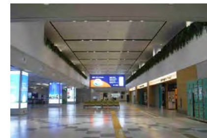
<ターミナルビルの吊り天井の事例(耐震対策後)>
