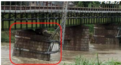
平成30年7月豪雨により傾斜した橋脚
