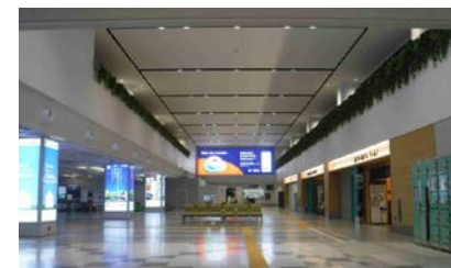
<ターミナルビルの吊り天井の事例(耐震対策後)>
