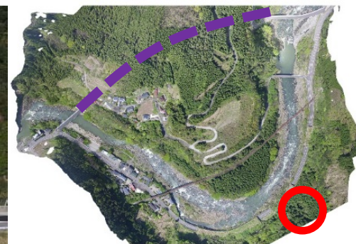
落石発生箇所
