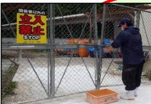
フェンス設置
