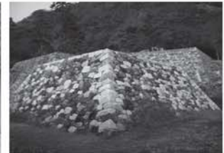
石垣の崩落防止
