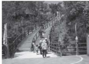
遊歩道の整備
