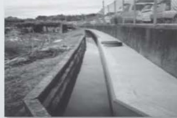
用排水路の補修・改修
