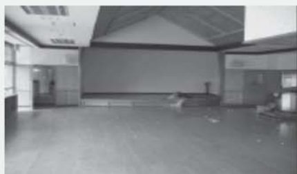
改修前(遊戯室)
