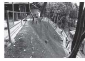
地盤の崩落防止
