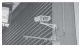
防犯カメラの設置
