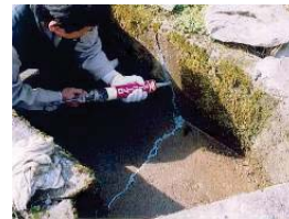
水路のひび割れ補修
