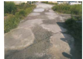
農道の窪みの補修
