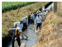
水路の泥上げ
