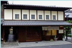
町家を現代窓に改修し、ギャラリーとして利用
