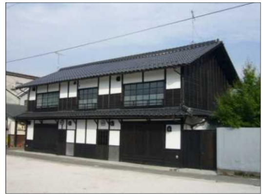
【広島県庄原市】 長屋住宅を交流・展示施設として活用
