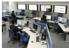
【リアルタイム検知ネットワークシステム】
