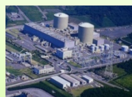
原子力発電所
