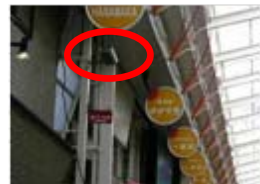
【アーケードに設置された防犯カメラ】
