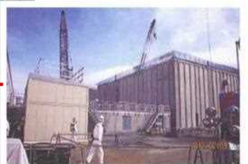
廃スラッジ一時保管施設
