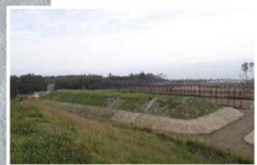
覆土式一時保管施設
