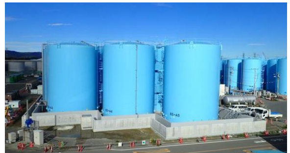
図4 溶接型タンク
