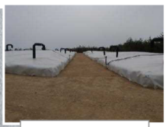
伐採木一時保管槽
