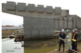
被災した橋梁の健全性調査の様子
