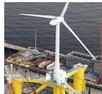
洋上風力発電設備 (H25.8現地設置)
