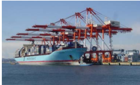
世界最大級の船が利用可能な大水深岸壁
