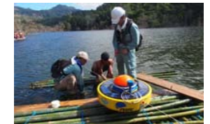
水位観測ブイの設置状況
