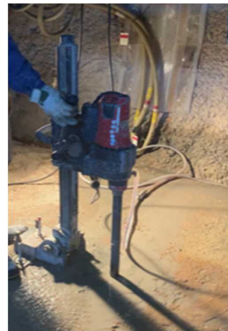
掘削影響領域に関する原位置試験 (天然バリアの自然事象を考慮した長期特性に関する研究、 原子力規制庁撮影)
