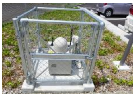
可搬型モニタリングポスト 【53局】 (常時設置)
