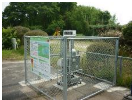
可搬型モニタリングポスト 【11局】 (常時設置)
