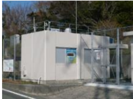
モニタリングステーション等【5台】
