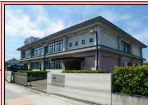
佐賀県オサイトセンター (唐津市) (発電所からの距離約13km)
