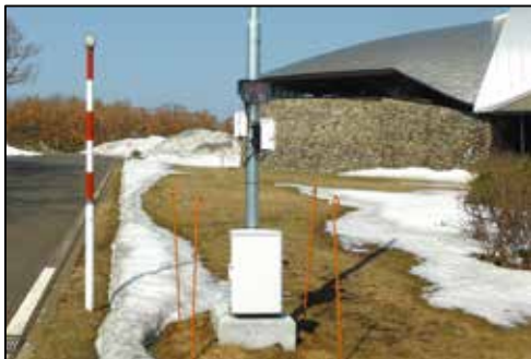
電子線量計【51局】 (非常用電源装備)
