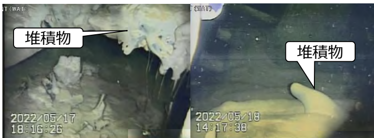
格納容器の底部の様子（5月調査時）
