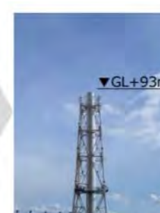
11ブロック解体後 (2020年2月4日)
