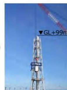
9ブロック解体後 (2020年1月17日)
