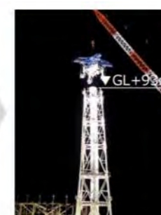
11ブロック解体時 (2020年2月1日)
