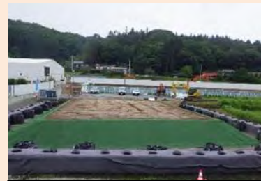
飯舘村実証事業における除去土壌を用いた盛土実証ヤード
